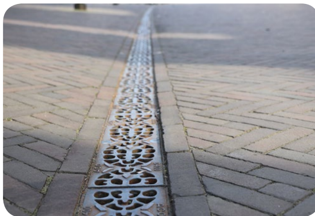
Een afwateringsgoot met negatieve ruimte in het rooster in Baarn.
