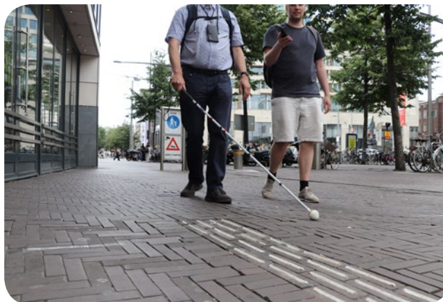
Een geleidelijn naar de start van een alternatieve route bij een complexe situatie in Den Haag.
